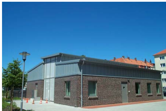
Hauptpumpwerk „oben“; Architekt: B. Wiedenroth
